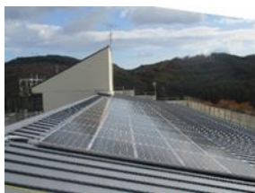
屋根への太陽光発電設置
