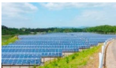
メガソーラー（太陽光発電所）
